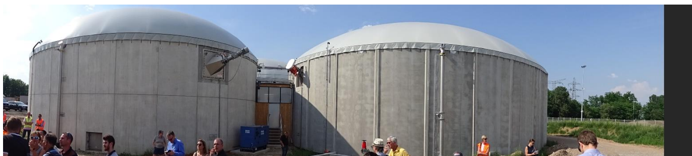
Photo 3 : Vue d'ensemble des 2 digesteurs
