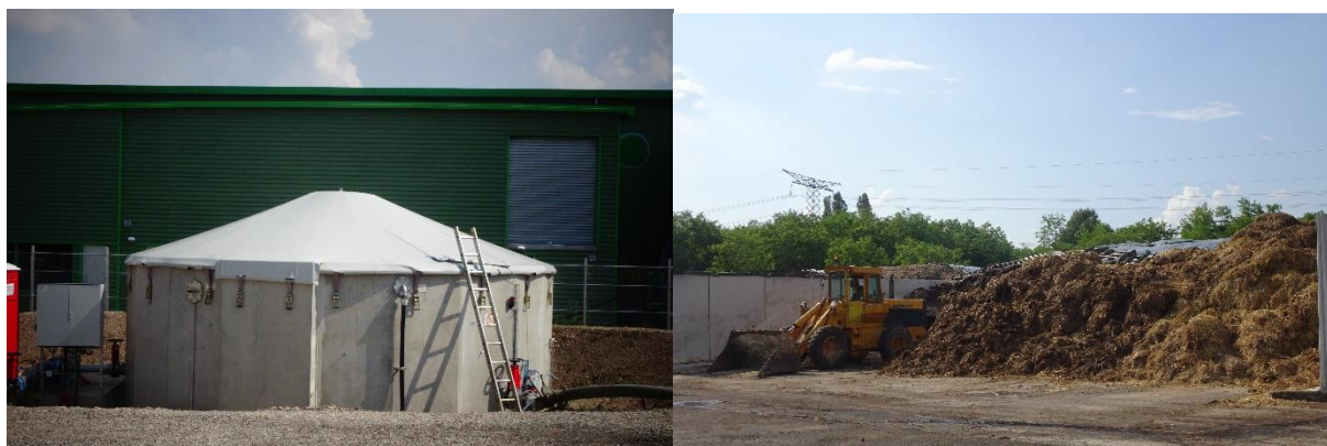
Photo 1 : Fosse de stockage lisier et silos pour intrants solides
